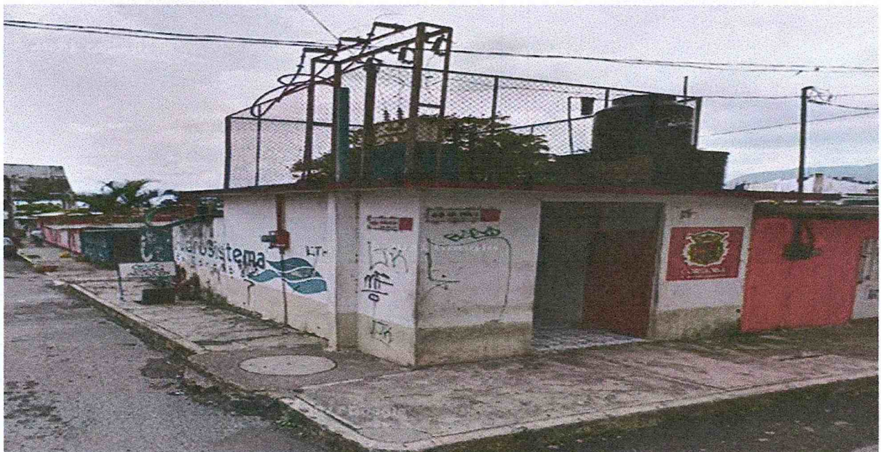
CARCAMO DE AGUA EL PUEBLITO H004
